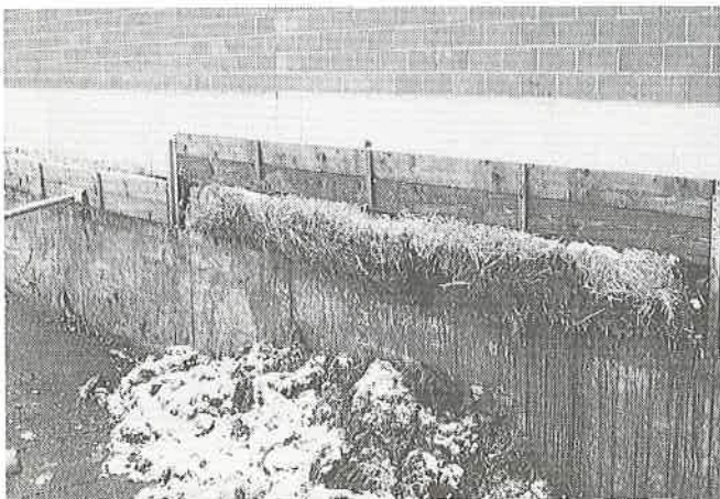
Abb. 15: Der Mist fällt durch eine Öffnung in der Rückwand in ein Mistsilo.
