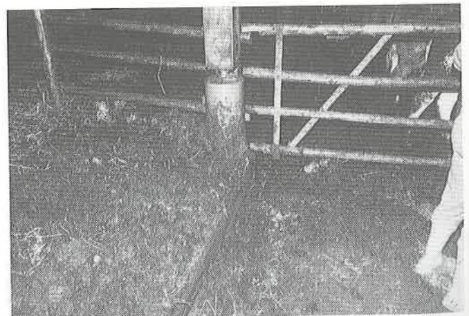
Fig. 23: Les pieds de supports qui sont en contact avec le fumier, devraient être non-corrosifs et de coupe transversale ronde ou ovale (afin de ne pas freiner le flux du fumier).
