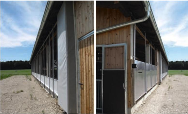
Les stores (à gauche) ou les fenêtres coulissantes (à droite) permettent d'adapter la surface des ouvertures aux conditions climatiques du moment.
