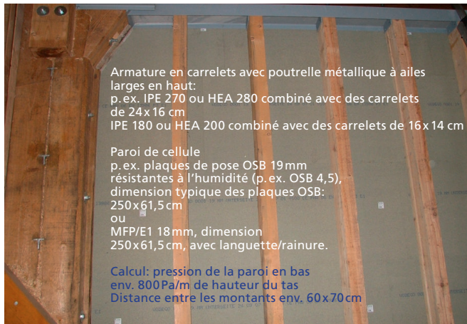
Fig. 4: Conception de la paroi d'une cellule.
