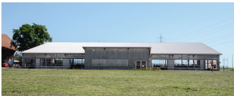
Dans une étable, les différentes exigences de température sont comblées au mieux avec une zone de traite dotée d'une isolation thermique et des aires de couchage et d'affouragement non isolées.
