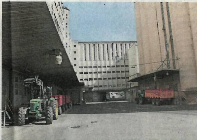
Chaque véhicule de livraison doit passer deux fois sur le pont à bascule, ce qui provoque un engorgement lors de fortes affluences.
