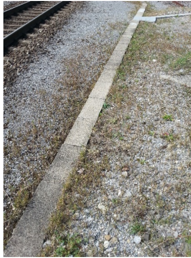
Regensdorf, Bahnhof (Althardstrasse in Kurve Richtung Watt); Bankett und Unterhaltsweg.
