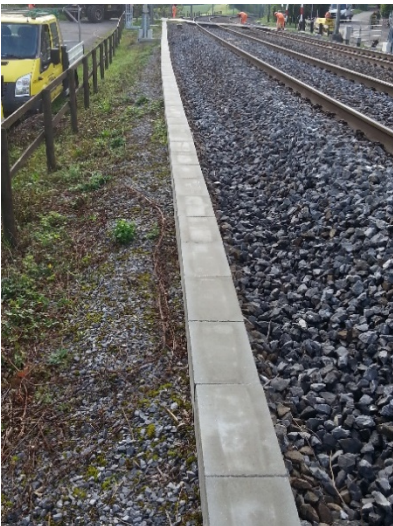
Altburg, Bahnübergang Burghofstrasse; der Kabelkanal trennt Gleise und Böschung.
