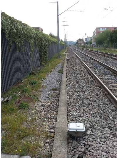
Zürich Affoltern, Bahnübergang Blumenfeldstrasse, links- und rechtsgleisig, Blick nach Osten; Kabelkanal trennt Gleise und Unterhaltsweg. Die Vegetation ist auf jeder Seite unterschiedlich ausgeprägt.
