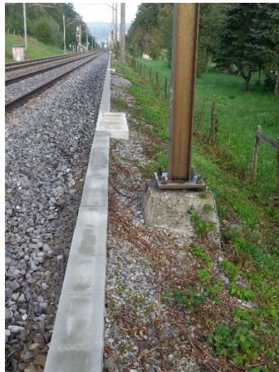
Altburg, Bahnübergang Burghofstrasse; der Kabelkanal trennt Gleise und Böschung.
