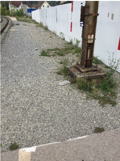
Baden, Bahnhof; Unterhaltsweg. Vegetation siedelt sich an Kanten an und breitet sich dann flächig aus.
