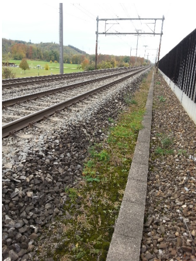
Bankett mit Schotterfüllung
