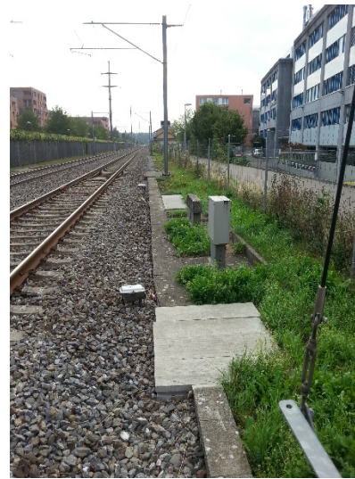
Zürich Affoltern, Bahnübergang Blumenfeldstrasse, links- und rechtsgleisig, Blick nach Osten; Kabelkanal trennt Gleise und Unterhaltsweg. Die Vegetation ist auf jeder Seite unterschiedlich ausgeprägt.
