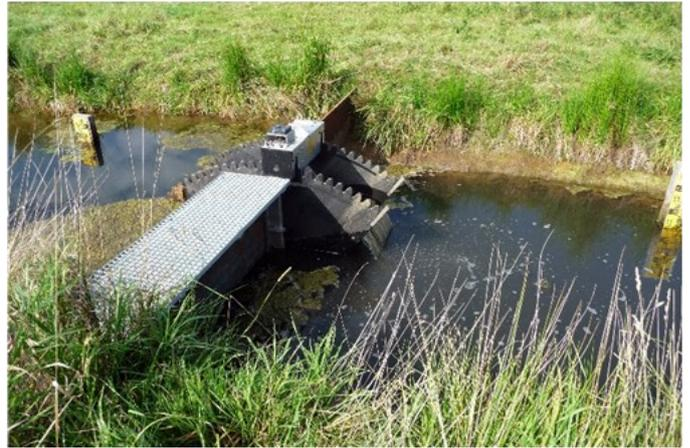
Figure 7: Barrage à clapet pour la remise en eau. La hauteur de l'eau dans les fossés peut ainsi être régulée au centimètre près. Photo: Uwe Fuellhaas / DBU Naturerbe GmbH
