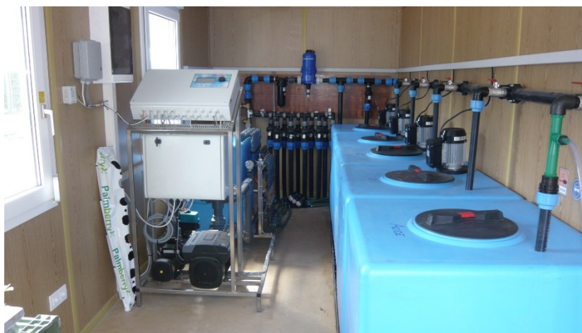
Figure 5. Automate pour la préparation de la solution nutritive adaptée pour les cultures de baies sur substrat
