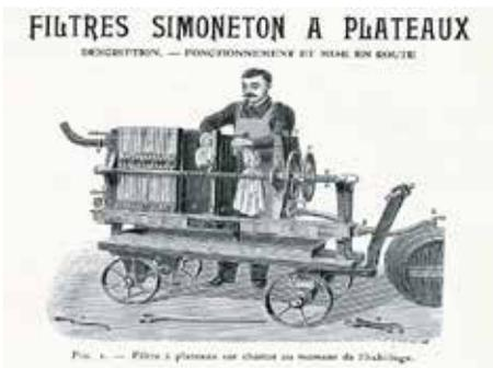
Abb. 5: Mobiler Schichtenfilter aus den 1920er-Jahren. (© Revue de viticulture)
