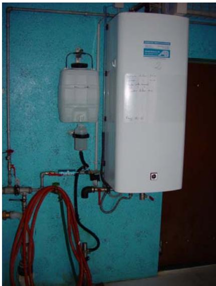
Boiler zur Aufbereitung von Heisswasser für die Reinigung nach dem „Heisswasser-Säure-Verfahren“ (mind. 97°C). Der Papierfilter am Ausgang des Boilers, der die Kalkpartikel aufhält, muss wöchentlich kontrolliert und wenn nötig ausgewechselt werden, da sonst der Wasserdurchlass abnimmt.
