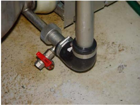
Wenn das Entleerungsventil der Melkanlage so nahe am Boden montiert ist, sollte dieses nach der Entleerung während des Tages geschlossen bleiben.
