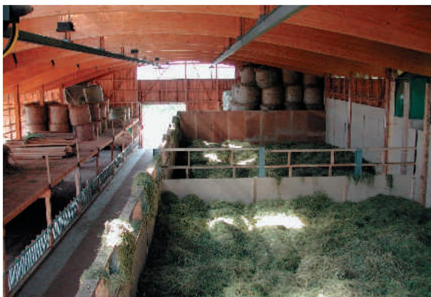
Abb. 6: Bergeräume für loses Futter brauchen mehr Lagervolumen als jene für Ballen; sie benötigen zudem Einrichtungen für den Futterumschlag.
