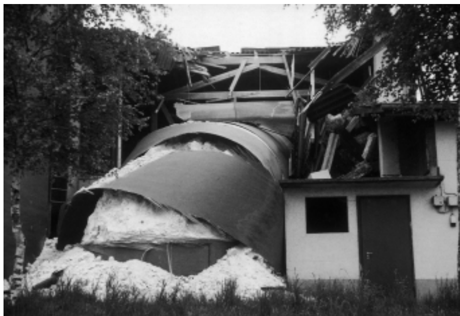
Abb. 2: Besonders wenn Silos auf Gebäude umstürzen, können hohe Sachschäden entstehen. In diesem Fall 150 000 Franken.
