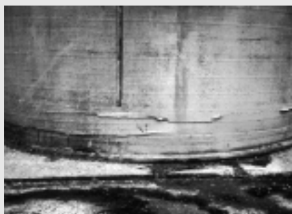
Abb. 12: Silos auf äussere Schäden beobachten. Es können mechanische oder altersbedingte Schäden auftreten.
