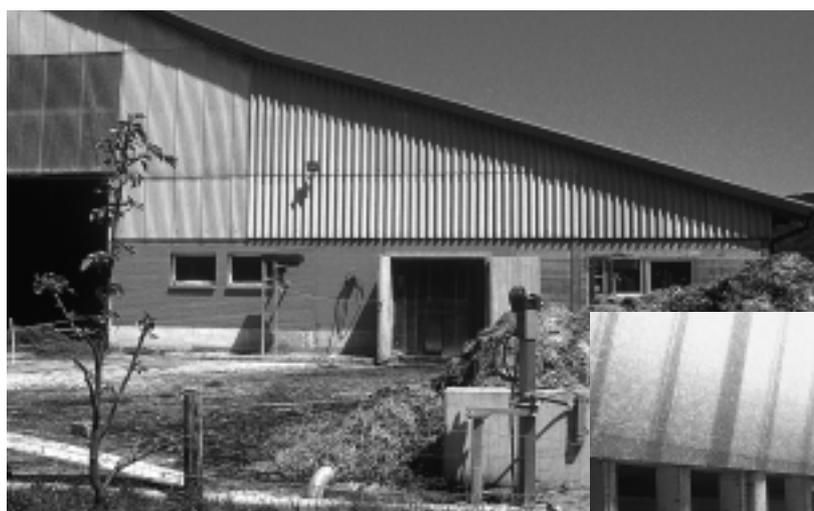
Fig. 1: Transformation d'une étable en stabulation entravée en une étable en stabulation libre en annexant une halle de repos sur le côté.
