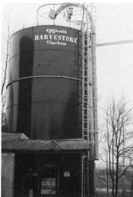
Fig. 1: Pour conserver les grains ensilés à plus de 60% de MS, il faut un silo parfaitement étanche au polyester vitrifié (GFK) ou en acier.
