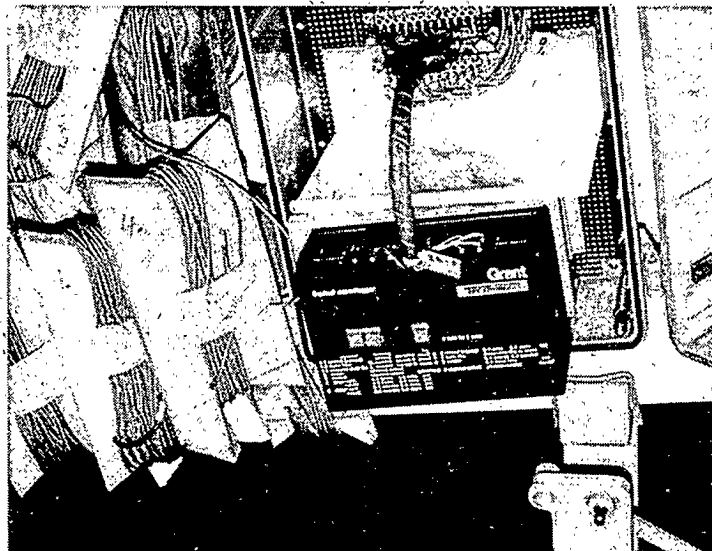
Abb. 29. Im Kollektorkanal registriert ein Data-Logger (Grant, Typ Logger SQ8-16U-32K) in Zeitabschnitten von 30 Minuten die Temperatur, welche von 16 Temperatursonden gemessen wird.
