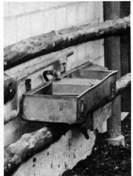
Abb. 9. Die Tränke im Auslauf muss frostsicher ausgebildet sein.
