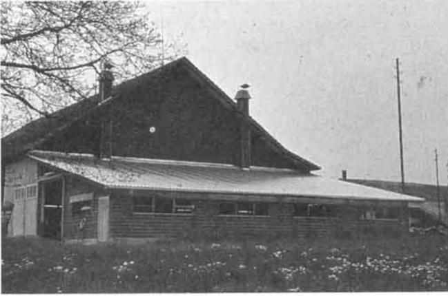
Abb. 33: Dieser Stallanbau enthält als Dach einen Kollektor von 190 m<sup>2</sup> mit durchsichtiger Polyesterabdeckung. Die Luft tritt bei der Traufe in den Kollektor ein, fließt nach oben und wird vom Lüfter von beiden Seiten zur Mitte gesaugt.
