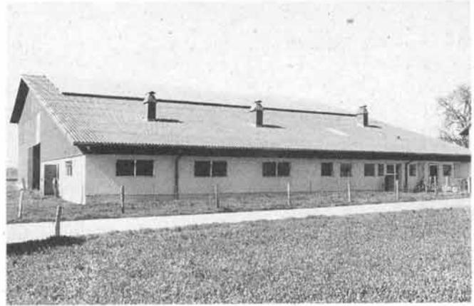
Abb. 34: Ein Aufbaukollektor aus Alu-Blech, montiert auf eine bestehende Scheune. Die zweite Pfettenlage kommt auf das bestehende Eternitdach zu liegen. Dieses ist nur in der Mitte unterbrochen, damit die Luft in den darunter liegenden Sammelkanal einströmen kann.
