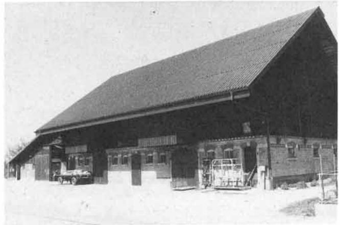
Abb. 7: Blechkollektor als Ersatz des alten Ziegeldaches. Luft-eintritt auf der Rückseite des Firsts. Der Sammelkanal führt die Luft unter dem Vordach von beiden Seiten zum Lüfter.
