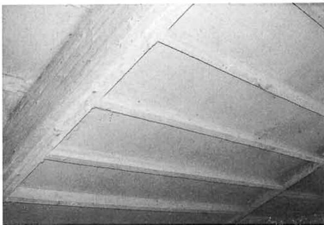
Abb. 23: A: Am Binder angeschlagene Balkenschuhe tragen die Balken des Sammelkanals.
