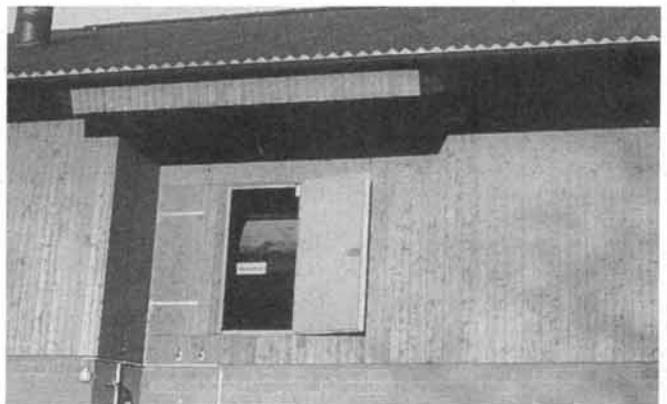
Abb. 16: Lüfterraum zwischen Heustockeinwandung und Fassade. Eine Türe sichert den Zugang zum Lüfter und erlaubt einen direkten Lufteinlass.
