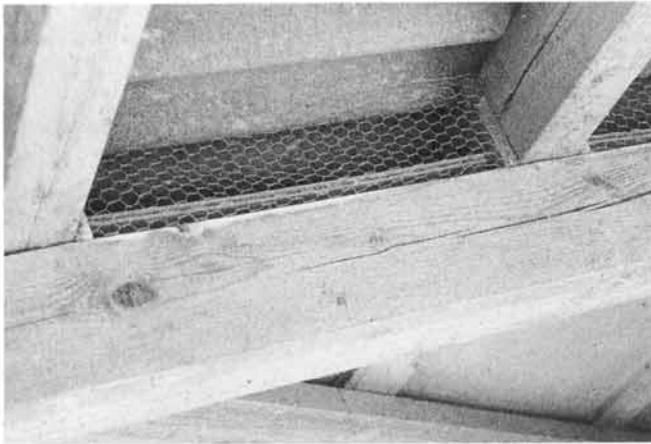
Abb. 21: Lufteinlass am Ortgang. Ein engmaschiges Netz verhindert das Eindringen von Vögeln.
