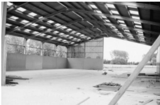
Fig. 17: Fumière couverte. En France, le fait de couvrir la fumière permet, suivant la consistance du fumier, de réduire le volume de stockage du purin (jus de fumier et précipitations) de 25 à 75 %.
