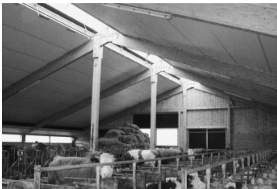
Fig. 10: Etable isolée D2. Les logettes opposées ne se trouvent pas en ligne, mais sont décalées latéralement (0,5 x largeur de la logette). L'espace entre les logettes est accessible avec le chargeur automoteur (épandage de litière).
