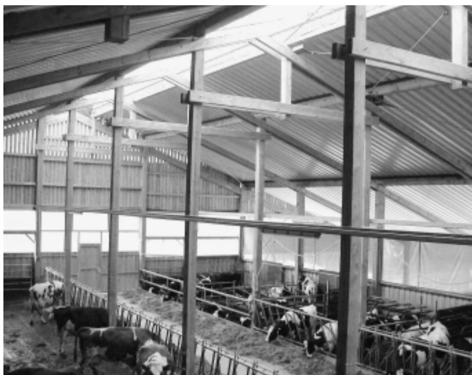
Fig.1: Etable spacieuse non isolée avec enveloppe de bâtiment très simple. Toiture légère avec tôle trapézoïdale autoportante.
