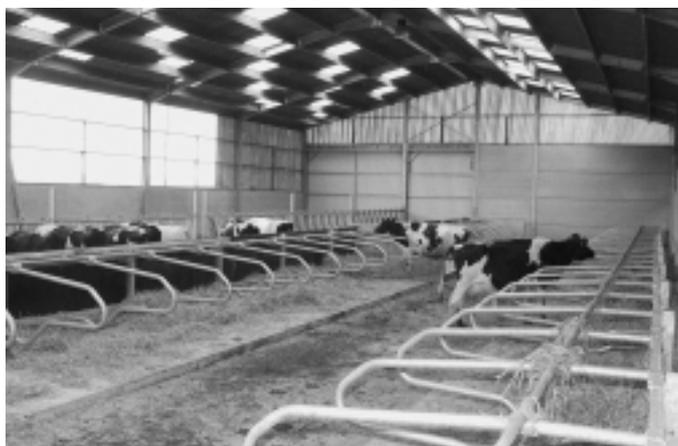
Fig. 15: Etable non isolée F3. Halle centrale en acier avec annexe sur un côté. Dans le couloir de circulation, on produit du fumier, dans le couloir d'affouragement du lisier complet.
