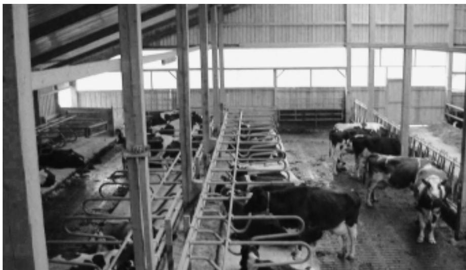
Fig. 11: Étable non isolée D3. L'aire de repos se compose de logettes surélevées équipées de matelas souples qui sont recouverts de chaux.
