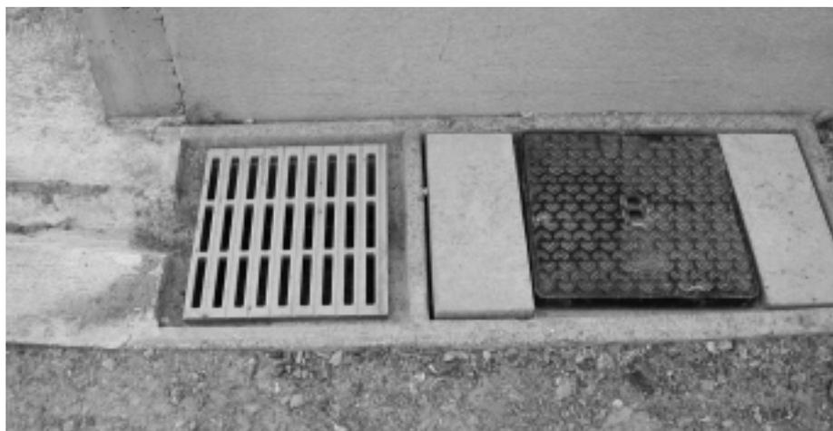
Fig. 2: Pour empêcher que la fosse ne déborde en cas d'orage, on prévoit un dispositif séparateur réglable à deux chambres du type « déversoir d'orage », qui permet l'écoulement des eaux pluviales par infiltration en surface.
