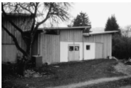
Fig. 8: Etable non isolée A4. Le bâtiment se compose de trois toitures en appentis contigus en tôle trapézoïdale autoportante.
