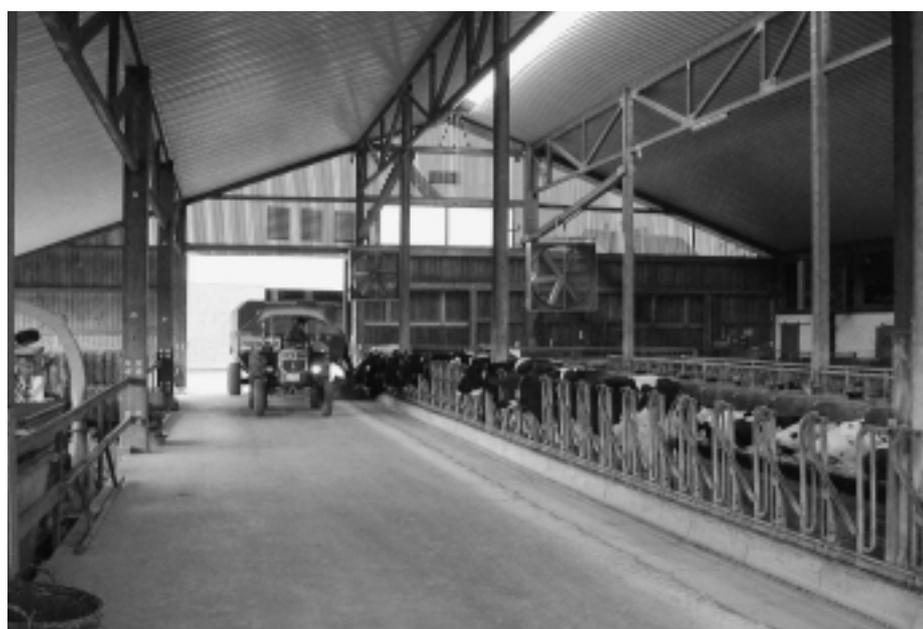
Fig. 9: Etable non isolée D1. L'étable préfabriquée possède une toiture composée de fermes placées en longueur et d'une couverture en tôle trapézoïdale autoportante. La voûte est ouverte (60 cm) et sépare le toit à double pente sur toute la longueur en deux toits en appentis. Piliers en bois encastrés.
