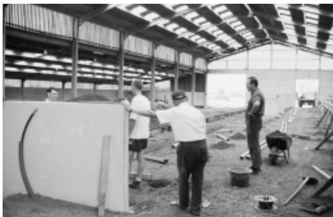
Fig. 14: Etable non isolée F2. Mêmes structure métallique que F1. Les aménagements intérieurs ont en grande partie été réalisés par l'agriculteur lui-même. Les panneaux lumineux du toit donnent de la lumière en abondance.
