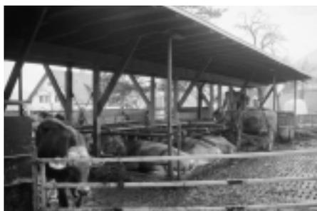
Fig. 7: Etable de construction simple A2. L'aire de repos est simplement protégée par un toit plat.
