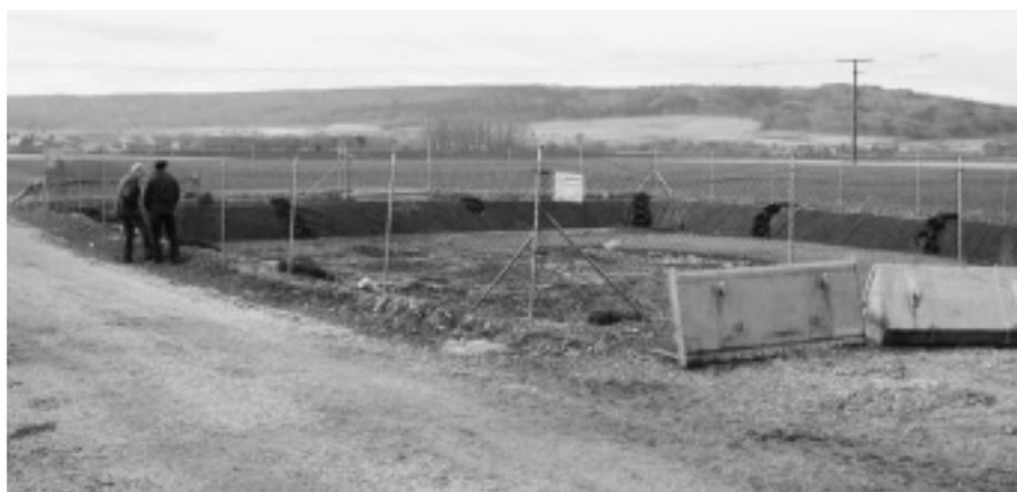
Fig. 19: Stockage du lisier très bon marché dans une fosse en géomembrane ouverte (exploitations D1 et D3).
