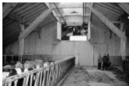
Fig. 5: Vue sur l'étable de vaches laitières isolée A1. Une ouverture dans la paroi séparant l'étable de l'entrepôt de foin construit à l'avant permet d'alimenter la crèche à l'aide d'une grue à griffe sur tourelle.
