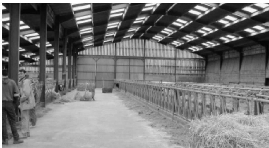
Fig. 13: Étable non isolée F1. Halle centrale en acier avec annexe sur les deux côtés. Les panneaux préfabriqués pour les parois reposent sur les fondations des piliers métalliques, des deux côtés.
