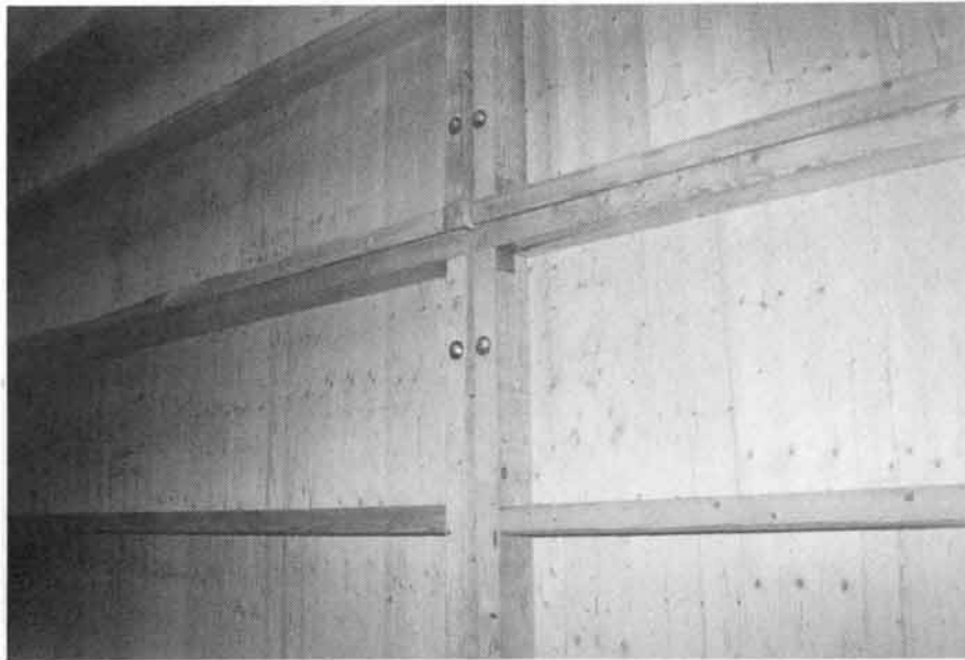
Fig. 29: Les éléments de cloison amovibles doivent être bien calfeutrés. Juste au-dessus du sol, la pression d'air s'élève à 5 – 6 mbar (= 500 - 600 Pa).
