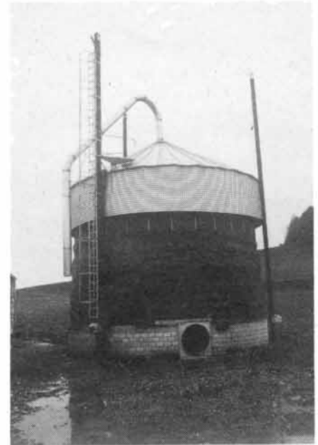
Fig. 3: Les tours à foin, de même que les installations de ventilation par le haut, ne se prêtent qu'à un léger postséchage et peuvent être utilisées pour prévenir l'échauffement spontané du foin. Pour autant que l'alimentation mécanique et le prélèvement mécanique du fourrage sont concernés, elles n'ont pas répondu aux attentes.
