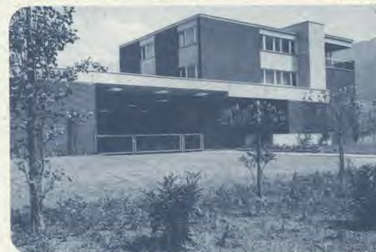
75/ Gebäude des Centro di Cadenazzo
