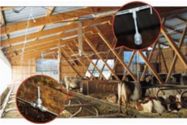
Abb. 3: Die Messanordnung im Stall bestand aus der Zudosierung von Tracergasen über ein Rohrsystem mit Kapillaren an den emittierenden Laufflächen und einem Luftsammlersystem mit Kapillaren in drei Meter Höhe jeweils an vielen Orten.
