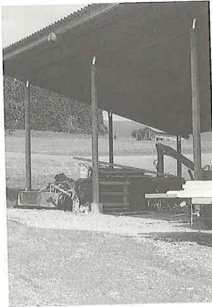
Abb. 2: Auch bei «Einfachbauten» sind Holzstützen vor dauernder Feuchtigkeit zu schützen, zum Beispiel durch einen Betonsockel. Solche einfache Massnahmen verlängern die Lebensdauer entscheidend.
