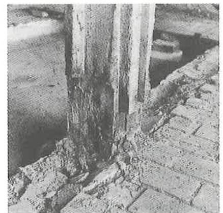
A) Stark angerostete Stahlstütze in Futterkrippe
