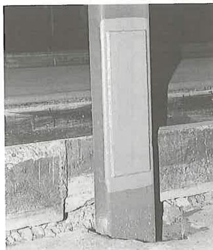
Abb. 11: Stahlstütze mit aufgeschweissten Lamellen zur Verstärkung des angerosteten Bereichs.
