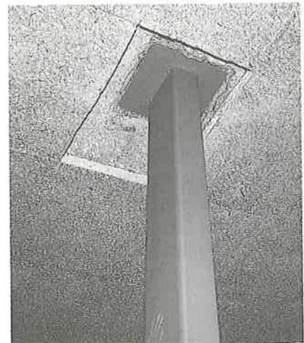
Abb. 12: Bei der Sanierung von Stahlstützen muss auch der Kopfbereich der Stütze freigelegt und allfällige Schäden behoben werden.
