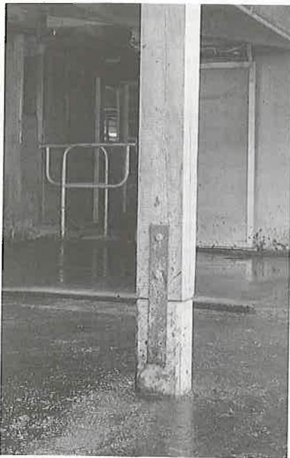
Abb. 8: Holzstütze in einem Laufhof. Die Verbindung von Betonsockel und Holzstütze erfolgt mit zwei seitlich angebrachten Flacheisen.
