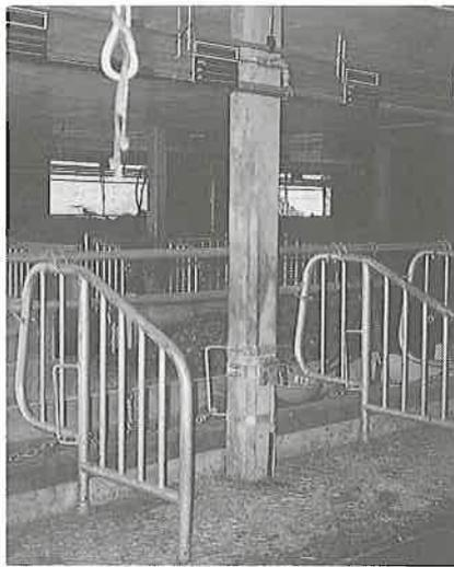
Abb. 4: Schlanke und gefällig wirkende vorgefertigte Betonstütze. Die Stalleinrichtungen sind mit Brieden befestigt und nicht eingedübelt, um die Stütze nicht zu verletzen.
