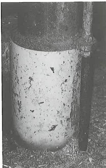
Abb. 6: Stahlstütze mit Kunststoffmanschette und Fließmörtelverguss. Wichtig ist eine einwandfreie und dauerhafte Verbindung des Fließmörtels mit der Stahlstütze.
