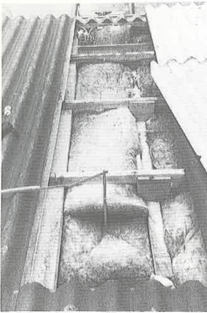
Abb. 4: Undichter Stoss zwischen zwei Steinwollematten.
