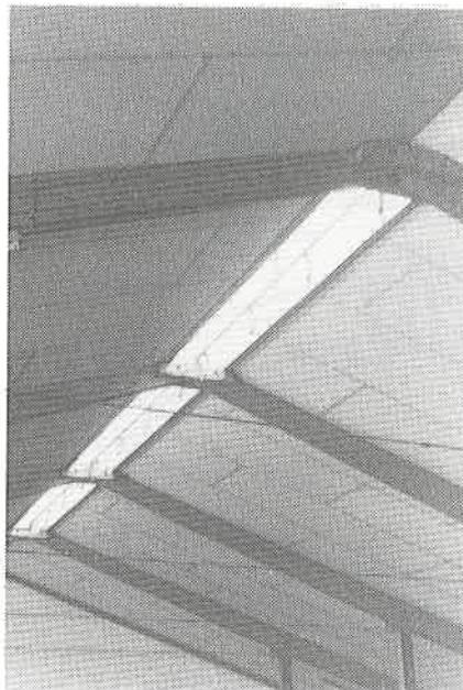
Abb. 15: Firstschlitzabdeckung, Wirkung als Lichtband.
