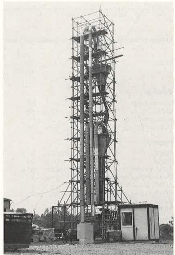
Abb. 1: Messturm mit den Rohrleitungen von 400 mm und 310 mm Durchmesser. Die das Futter auffangenden Trichter sind gut sichtbar.
