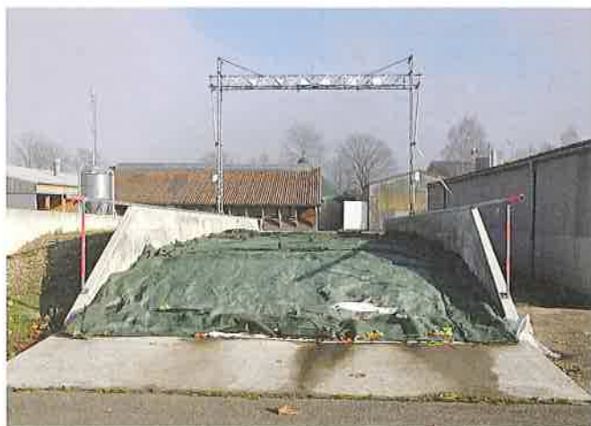
Dieser Flachsilo mit 6 m Breite und 26,5 m Länge diente für die Versuche. Oben im Bild ist die Ultraschallmessbrücke für die Volumenbestimmung des Silos sichtbar.
