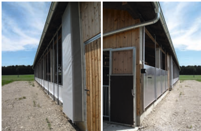
Mit Curtains (links) oder Hubfenstern (rechts) können die Öffnungen an die jeweilige klimatische Situation angepasst werden.
