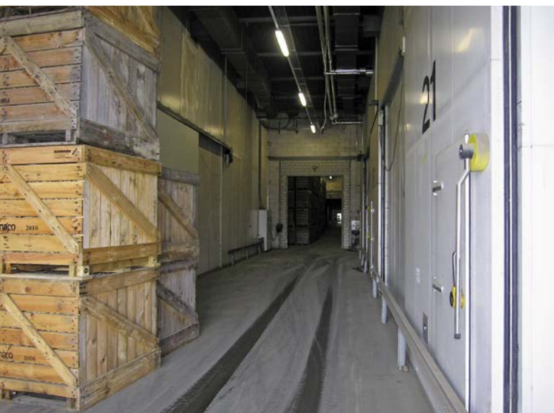
Figure 1 | Locaux frigorifiques pour le stockage des pommes de terre. (Photo: Gaétan Riot)
