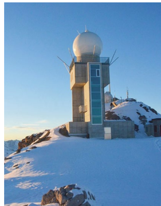
Die neue Wetterradar-Anlage auf dem Weissfluhgipfel.
