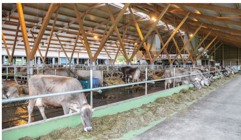
Un colmo aperto permette un ricambio dell'aria senza ostacoli e porta luce in stalla. L'ideale sarebbe avere l'apertura del colmo sopra il corridoio.
