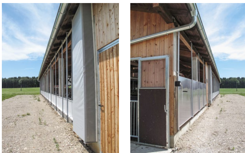
Tende (a sinistra) o finestre mobili (a destra) permettono di adattare le aperture della facciata alla situazione meteorologica.
