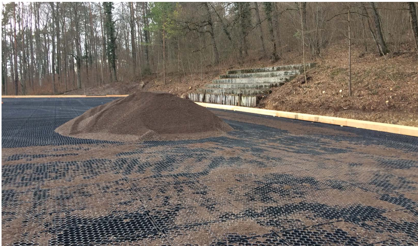
Figure 12: Les dalles alvéolaires perforées ou les briques composites en plastique sont des matériaux qui conviennent bien pour la couche de séparation. Elles sont faciles à installer et à remplir. (Source: Agroscope HNS; sauf la dernière image: Bruggmann Reitplatzbau)
