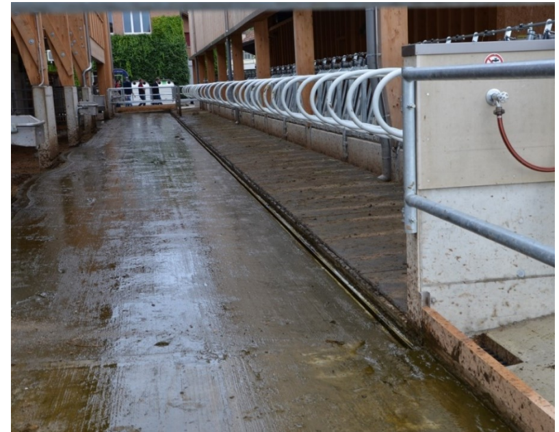
Milchviehstall Arenenberg – Laufgang mit 3 % Quergefälle und seitlicher Harnrinne (Pitzen, Agroscope 2021)
