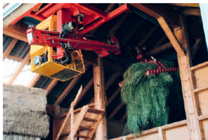
Comme les machines agricoles, les installations de mécanisation intérieure ont pour but de faciliter le travail et de réduire le temps de travail.
