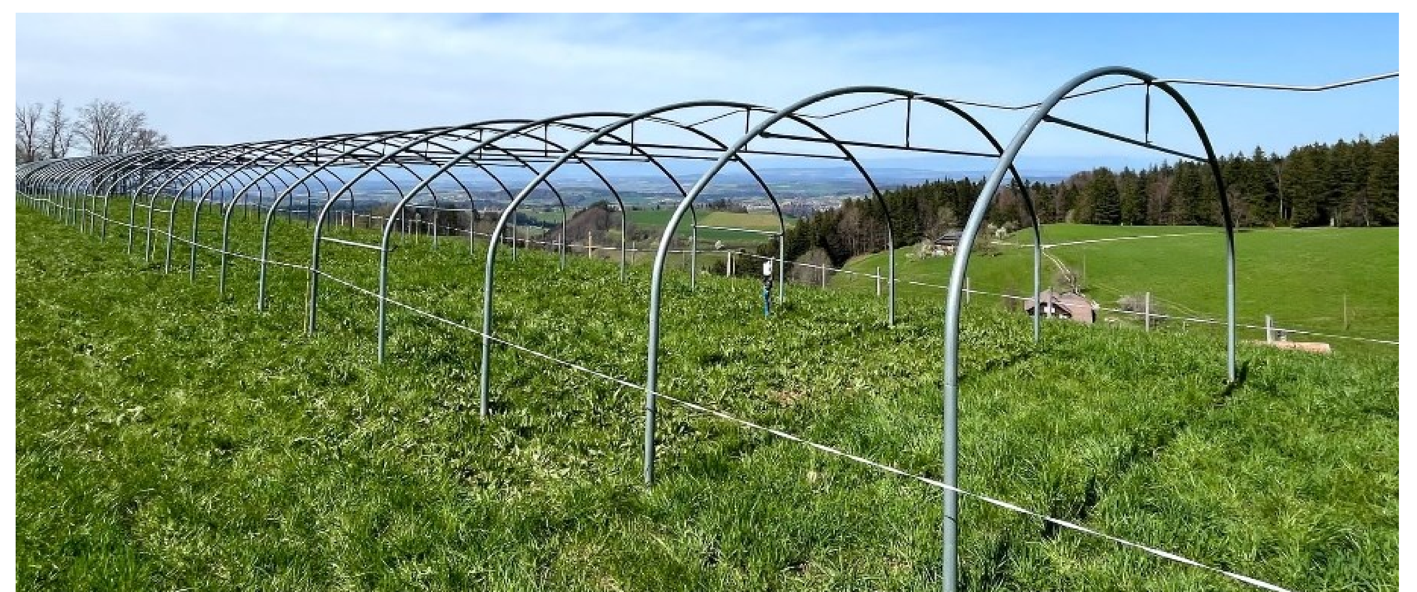
Armatures des tunnels sur le site du canton de Bern.
