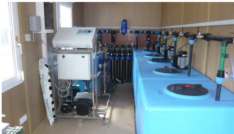
Abbildung 5. Automatische Mischanlage zur Herstellung der angepassten Nährlösung für Beeren auf Substrat.
