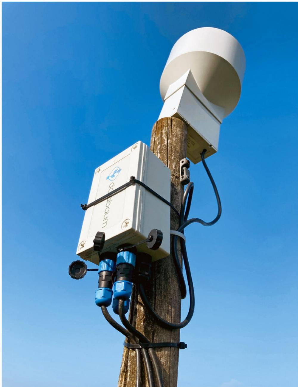
Abb. 1: Wetterstation von databaum mit einem Luftsensoren, Regenmesser, Blattsensoren und Bodensensoren. (© WBZW)
