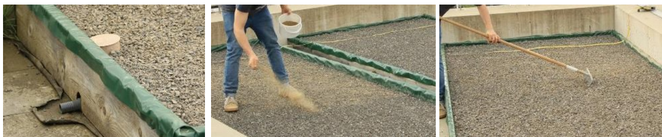
Entwässerung der Plots auf der Dachanlage und Ansaat von Hand. © Patrice Prunier
