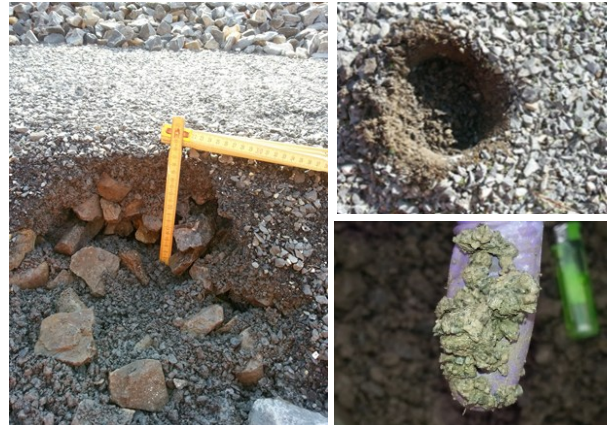
Abbildung 4: Typisches, auf den Gehwegen im Gleisbereich verwendetes Substrat
