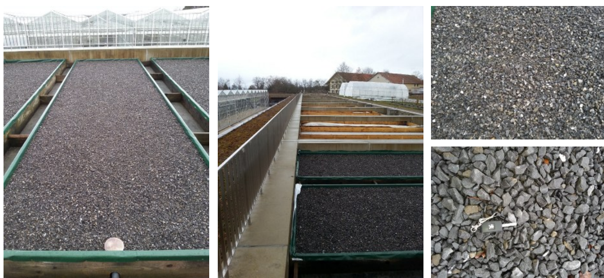
Figure 10: Toiture de Lullier (janvier 2020).
