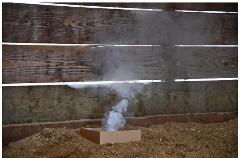
A gauche, exemple de fentes d'aération dans les parois des box permettant de diluer les gaz nocifs et la poussière dans l'air de l'écurie. A droite, la fumée permet de visualiser le flux d'air vers l'extérieur. | © Agroscope, HNS
