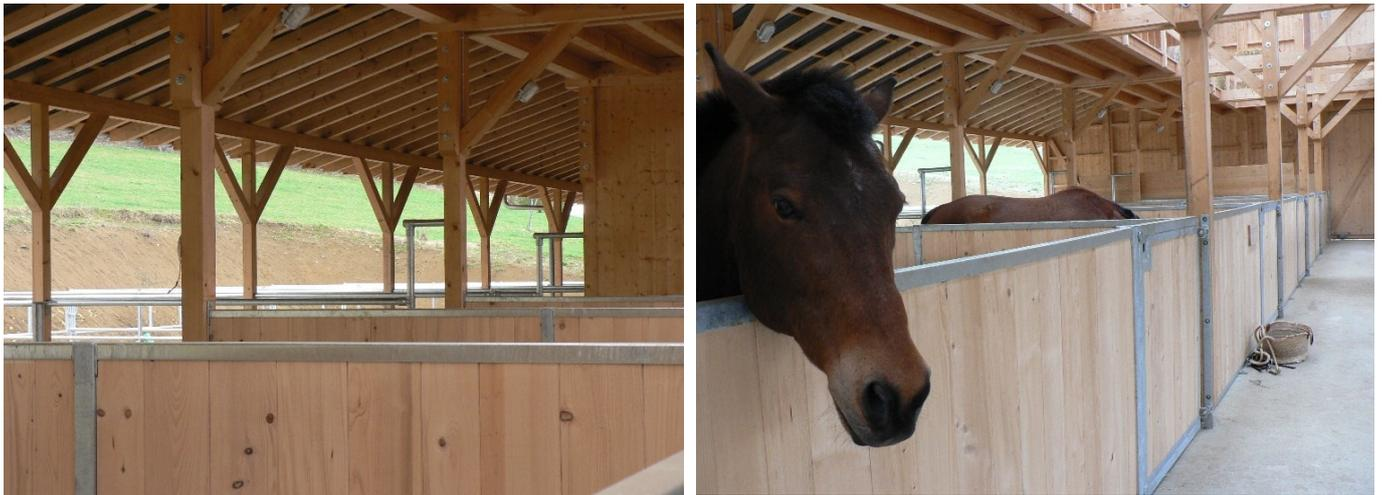
*A gauche : des parois latérales ouvertes permettent un échange d'air régulier.*
