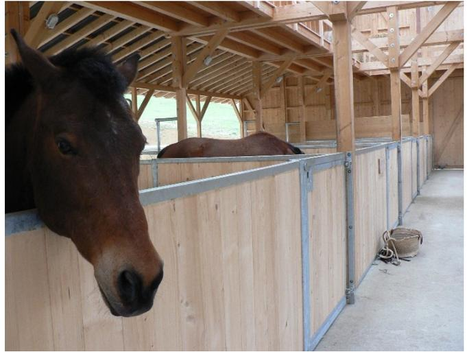
*Links: Offene Seitenwände ermöglichen einen gleichmässigen Luftaustausch im ganzen Stall.*
