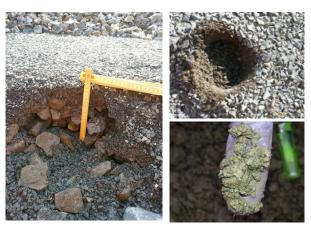
Figure 4: Substrat typique utilisé sur les chemins d'accès aux abords des voies.
