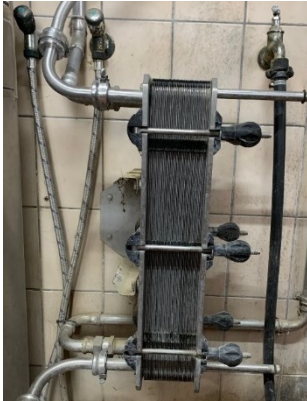
Figure 23: refroidisseur à plaques
