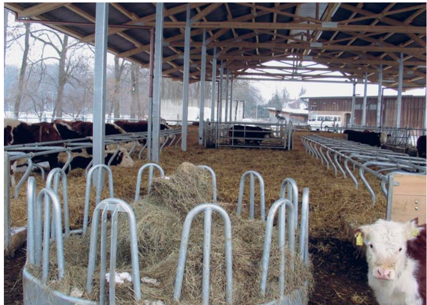
Abb. 17: Bei der Anordnung des Kälberschlupfs ist auf eine Zufahrt zum Entmisten der Liegefläche zu achten.
