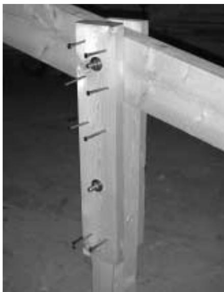
Abb. 13: Weil Bauschrauben relativ teuer sind und der Platz für mehrere Schrauben oft fehlt, ist es von Vorteil, Schrauben mit Nägeln zu kombinieren.
