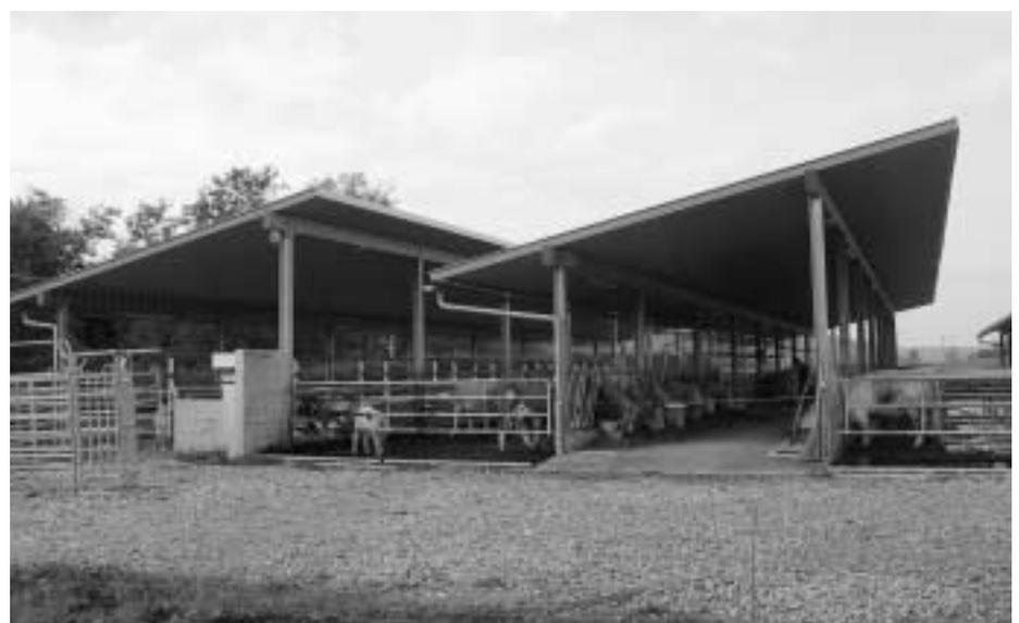
Abb. 11: Einfache Dachstruktur mit Trapezblech in einem Mutterkuhstall.
