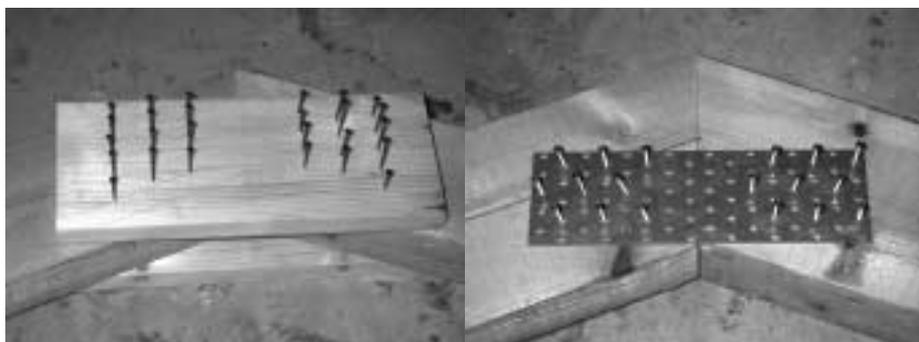
Abb. 15: Zwei gestossene Holzteile können nicht nur durch Holzlaschen, sondern auch durch Lochplatten (beidseitig) miteinander verbunden werden.
