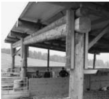
Abb. 4: Kälberstall in Rundholzbau. Die zu verbindenden Teile wurden bei den Stössen einander angepasst.
