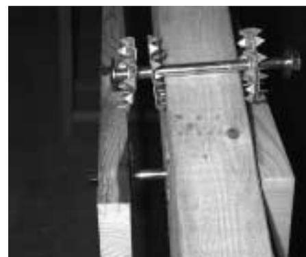
Abb. 14: Der Einbau von Einlassdübeln ist nur mit speziellen Werkzeugen (Fräse) möglich und bleibt in der Regel dem Zimmermann vorbehalten. Das Einpressen der Dübel (Typ Bulldog) durch Anziehen der Schrauben ist nur bei kleinen Durchmessern möglich.
