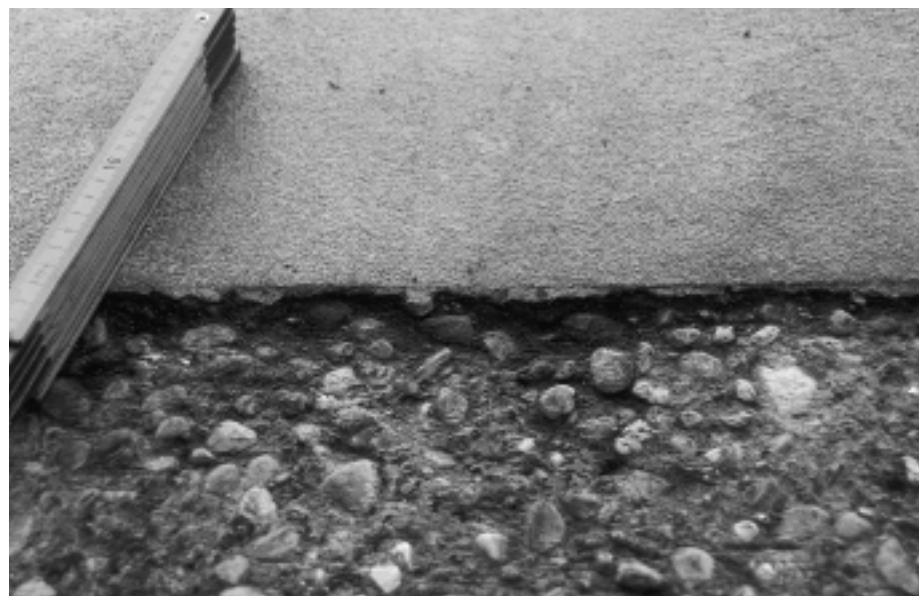
Fig. 10: Le revêtement de résine époxyde (bandes) dans le silo-couloir de la FAT est encore intact au bout de sept ans.
