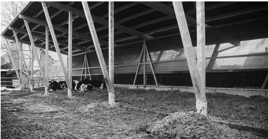
Fig. 2: Aire de repos non structurée avec couche de litière. Le mode de construction flexible constitue un avantage. Les bouses doivent toutefois être enlevées quotidiennement.
