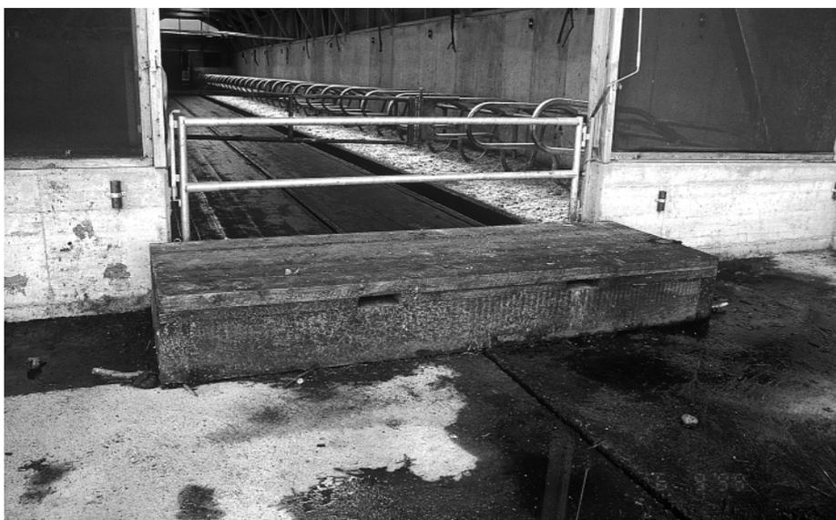
Fig. 11: Evacuation du fumier avec ouverture libre.
