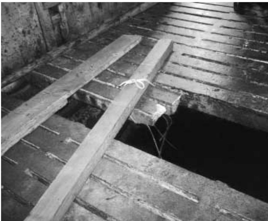
Abb. 1: Das plötzliche Versagen von alten Spaltenbodenelementen kann zu tödlichen Unfällen führen (Foto Roman Euler, SAB).
