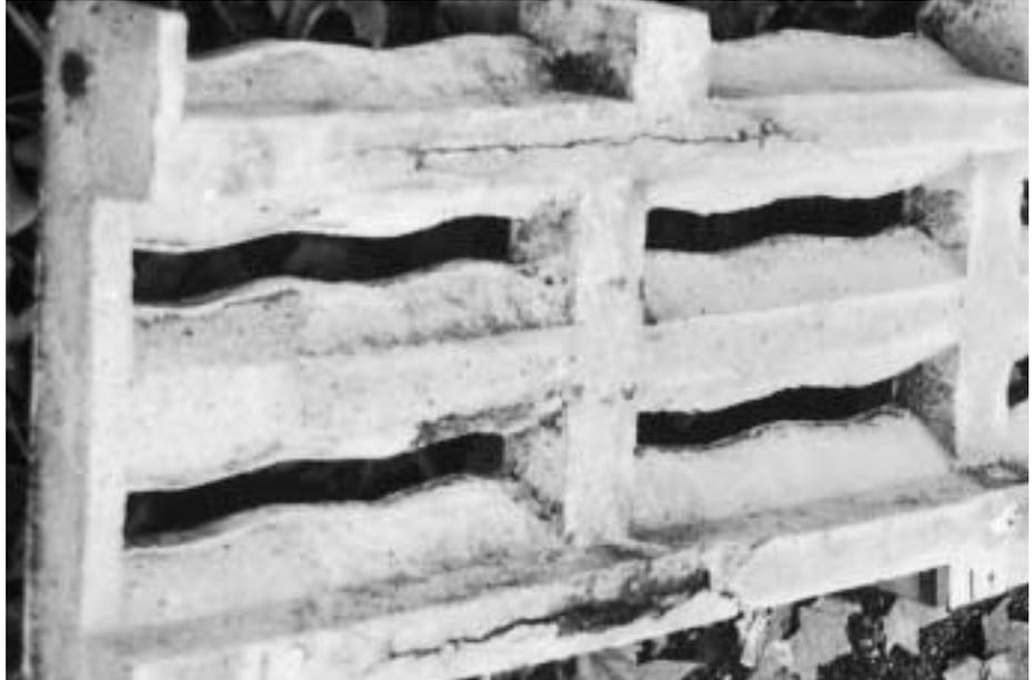
Abb. 2: Deutliche horizontale Risse unten am Elementende als mögliche Vorboten für das Versagen des Verbundes zwischen dem Armierungseisen und der Betonumhüllung.
