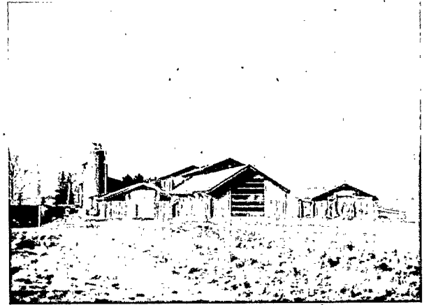
Futtertenn mit beidseitigen Liegehütten Windschutz mit Bretterzaun
