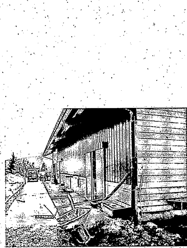
Laufhof im Bauzustand
