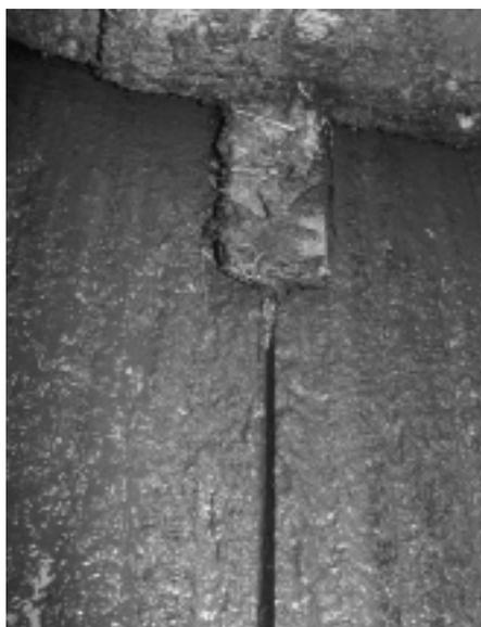
Abb. 24: Führungsrinnen für Breitschieber sind möglichst schmal auszuführen. Auf Betonoberflächen kann die Rinne direkt eingefräst werden.
