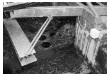
Abb. 13: Für Schubstangenanlagen haben sich zur Trennung von flüssigen Bestandteilen aus Langstrohmist Löcher mit einem Durchmesser von ungefähr 15 cm bewährt.
