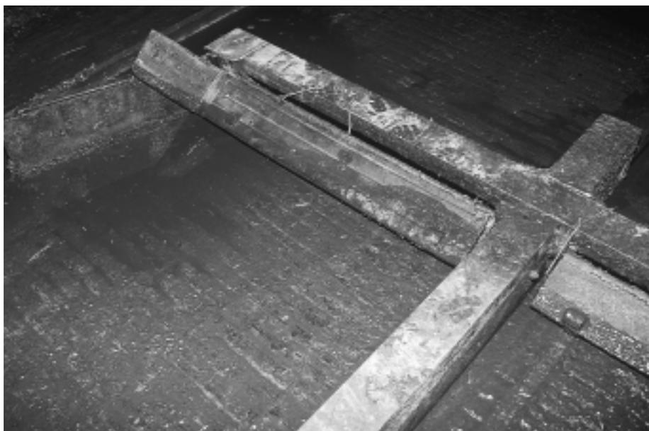
Abb. 6: Um die geforderte Trittsicherheit über Jahre zu gewährleisten, müssen Betonoberflächen profiliert sein. Verlaufen die Rillen in Gefällerrichtung, hilft dies dem Entwässern.
