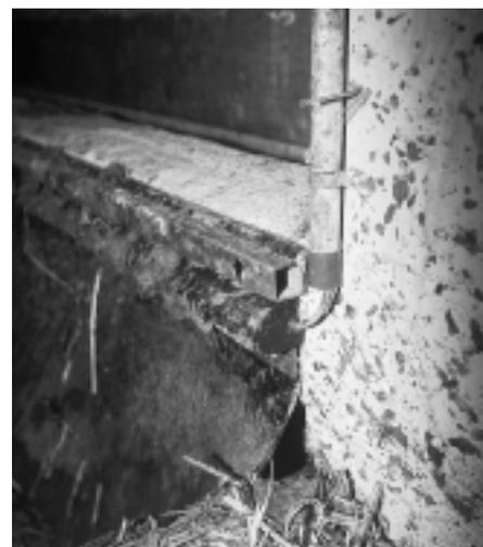
Abb. 21: Quetschstellen an Wanddurchbrüchen sind eine häufige Unfallursache. Kontaktleisten bewähren sich bei korrekter Montage gut. Ein genügend gross dimensioniertes Montageprofil verhindert Beschädigungen durch die Tiere.
