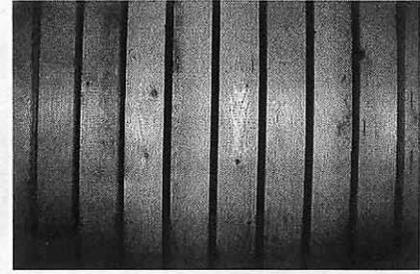
Abb. 6. Eine Wand kann man auf ganz einfache Weise grossflächig luftdurchlässig machen, indem man zwischen den senkrechten Brettern jeweils einen Schlitz lässt (Spaced Boards).
