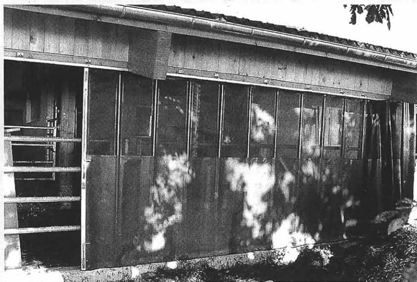
Abb. 8. Neben Rollwänden gibt es auch schiebbare Vorhänge, welche bei günstiger Witterung aufgemacht werden. Der untere Bereich kann als geschlossene Plane, der obere Bereich als Windschutznetz ausgeführt sein.
