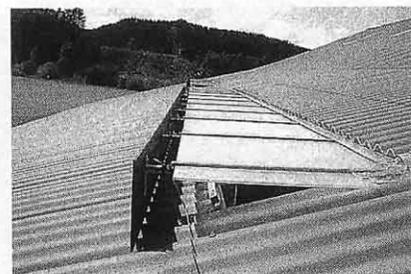
Abb. 19. Bei seitlich angebauten Ställen sorgen angehobene Dachplatten mit Windabweiser für eine gute Entlüftung.
